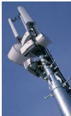
移動通信アンテナ（頂上）と極超短波通信アンテナ（円筒状）がついたアンテナ柱。後者は基地局と交換センターをつないでいる。
