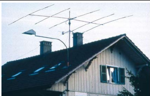
アマチュア無線用空中アンテナは大変違った形態をとりうる。 これは屋根にとりつける方式の八木社の空中アンテナである。
